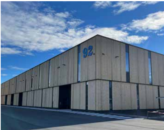
Laternerer Holz bei Kunert-Halle Bildquelle: Fa. Doblerbau
