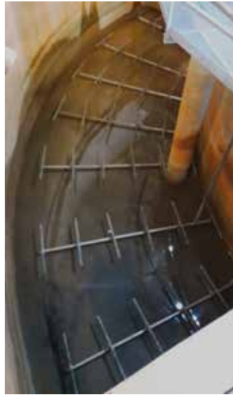
Belüftung für Belebungsbecken
