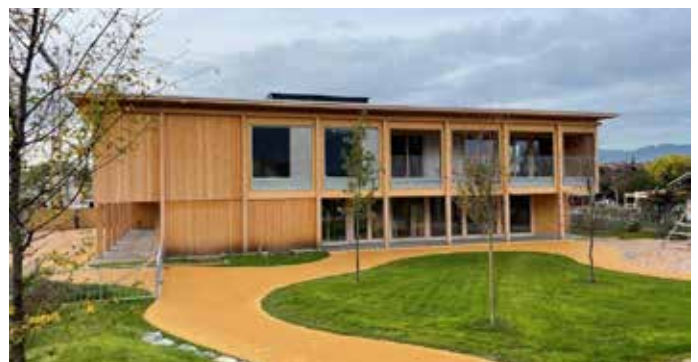
Holzverkleidung mit Holz aus dem Gemeindewald: Kindergarten und Kinderbetreuung Kreuzfeld Altach (Foto: Fa. Doblerbau)
